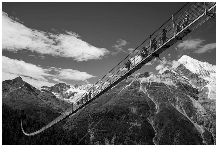
Рис. 10. Подвесной пешеходный мост
